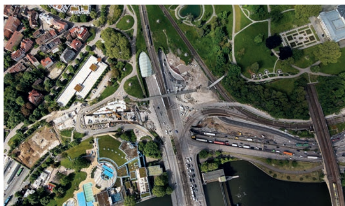
Bauarbeiten am Leuzeknoten. Foto: Thomas Hörner/Stadt Stuttgart
