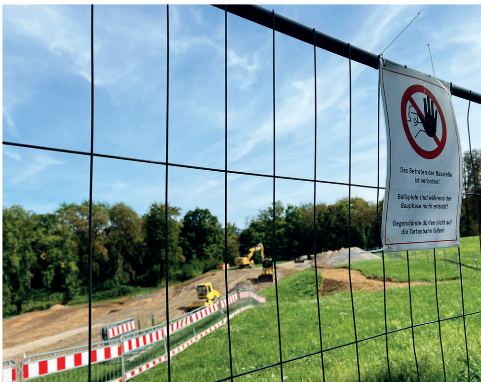
Bagger dominieren auf dem Gelände der früheren SWR-Fernsehstudios.
